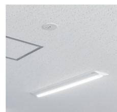
LED照明の採用で省エネ化を図るだけでなく、外光センサを採用し、窓側2列の照明を自動調光。昼間の照度をコントロールすることでさらなる節電効果を発揮できるよう設計しています。
